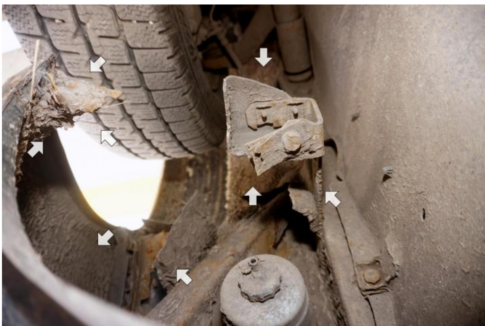
Fot. 32. korozja nadkoli i wnek kół
