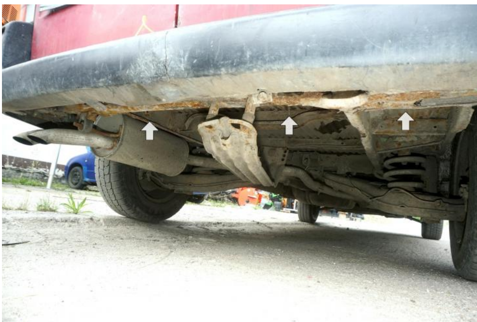
Fot. 25. intensywna korozja
