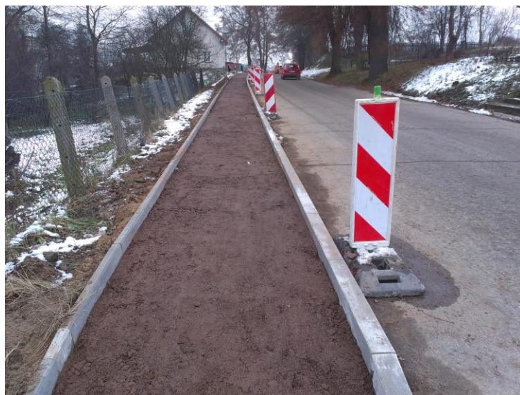
Remont chodnika w ciągu DP 1387N w Szylenach
