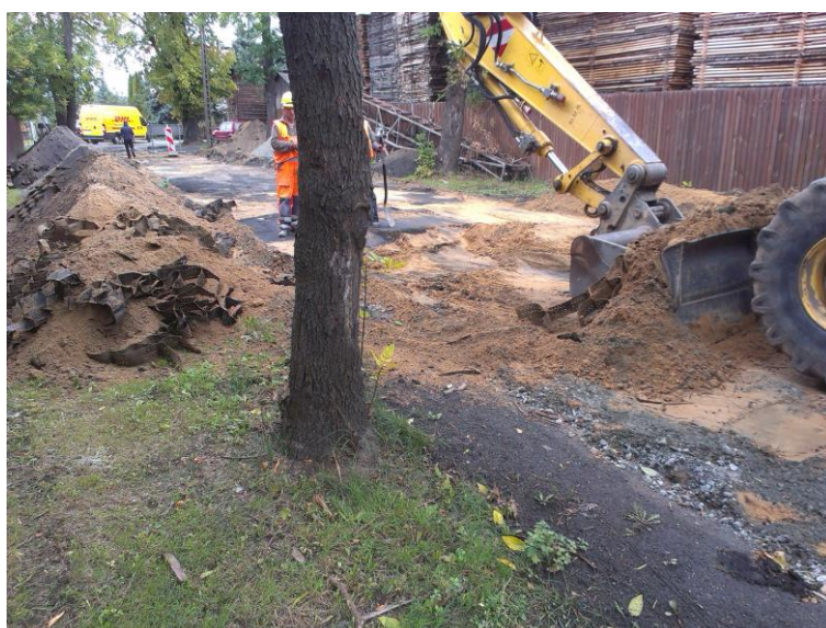
Rozbiórka niewłaściwie wykonanego odc. trasy rowerowej ul. Błotna w m. Frombork poprawki wykonawcy przed odbiorem
