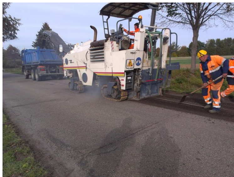
Frezowanie starej nawierzchni drogi powiatowej nr 1385N w m. Bemowizna
