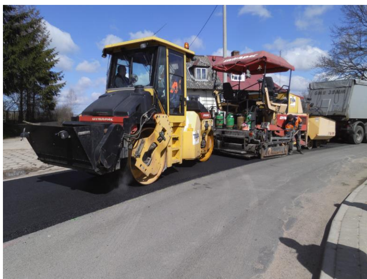
Naprawa nawierzchni jezdni DP 1397N- układanie warstwy MNU na odc. w m. Wyszkowo
