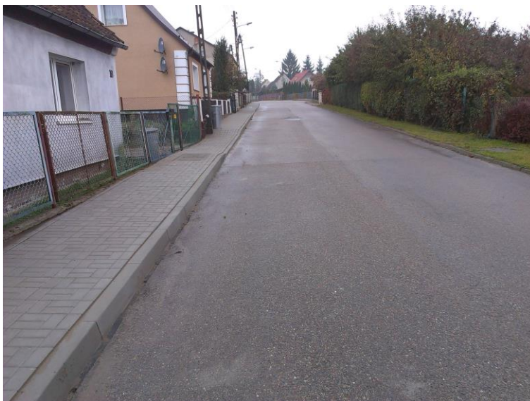
Naprawa nawierzchni chodników przy ulicach powiatowych we współpracy z Miastem Pieniężno
