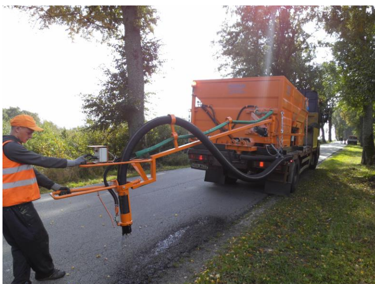
Bieżąca naprawa nawierzchni dróg powiatowych grysami i emulsją
