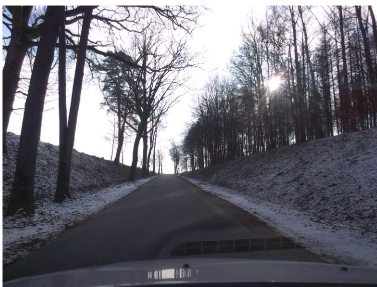
Pielęgnacja zieleni przydrożnej- usuwanie konarów suchych i ograniczających skrajnię drogi
