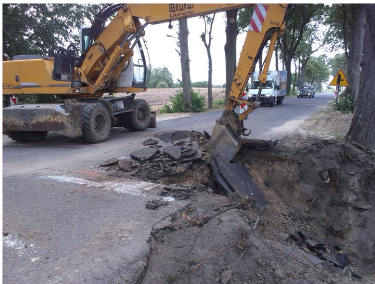
Przebudowa przepustu pod drogą nr 1397N w m. Pakosze
