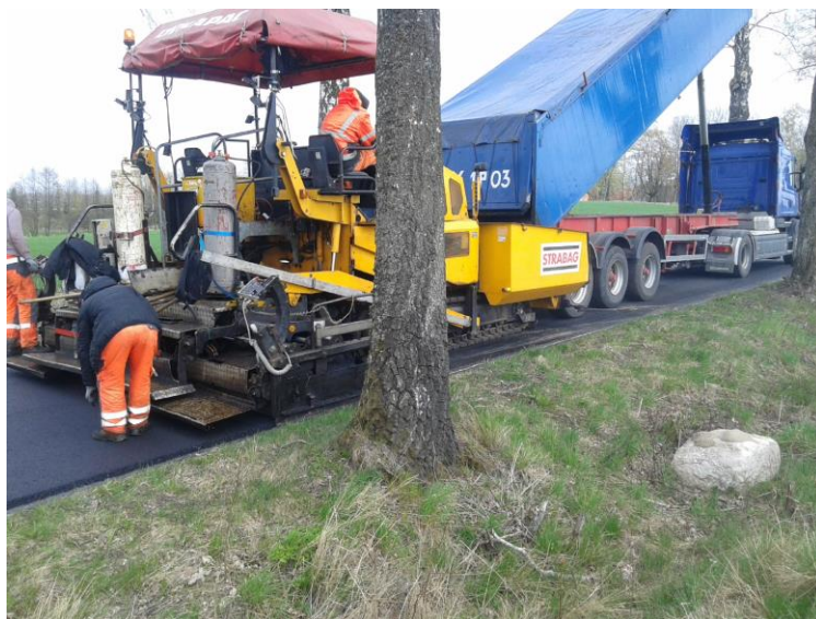
Układanie nowych nawierzchni jezdni w ciągu drogi powiatowej Lubnowo- Tolkowiec- Wysoka Braniewska
