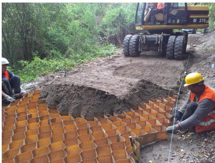
Wzmocnienie konstrukcji dróg gruntowych geokratami wypełnionymi kruszywem
