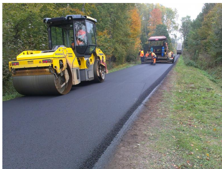
Wykonanie wyrównania i nowej nawierzchni na odc. Biedkowo Osada
