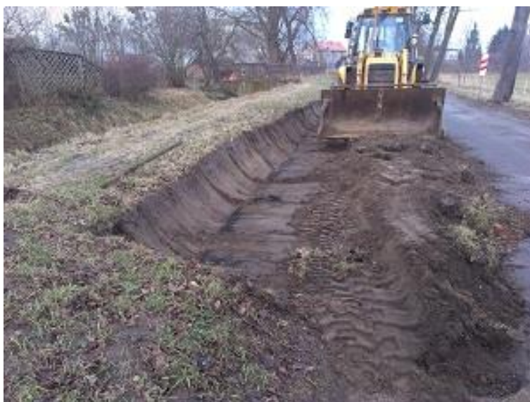
Zbieranie i profilowanie zawyżonych poboczy z wywozem ziemi
