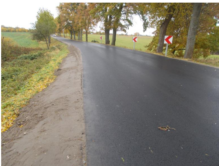
Poprawa warunków komunikacyjnych – wykonanie nowych nakładek w ciągu dróg powiatowych wraz z wzmocnieniem poboczy kruszywem
