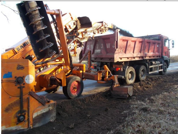
Mechaniczne ścinanie zawyżonych poboczy z wywozem ziemi
