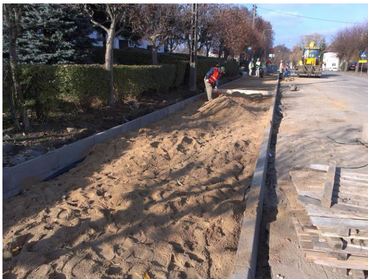
Plac Wolności w Pieniężnie budowa ciągu pieszo- rowerowego
