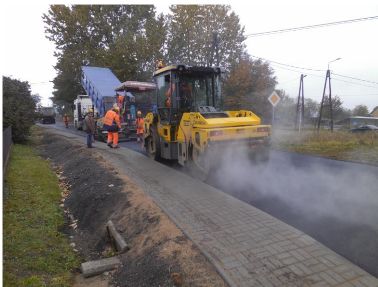
Układanie nowych warstw nawierzchni jezdni w ciągu dróg- poprawa warunków komunikacyjnych (nakładki)
