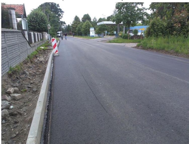
Nowa nawierzchnia jezdni i przebudowa chodnika w ciągu ul. Kościuszki w Pieniężnie
