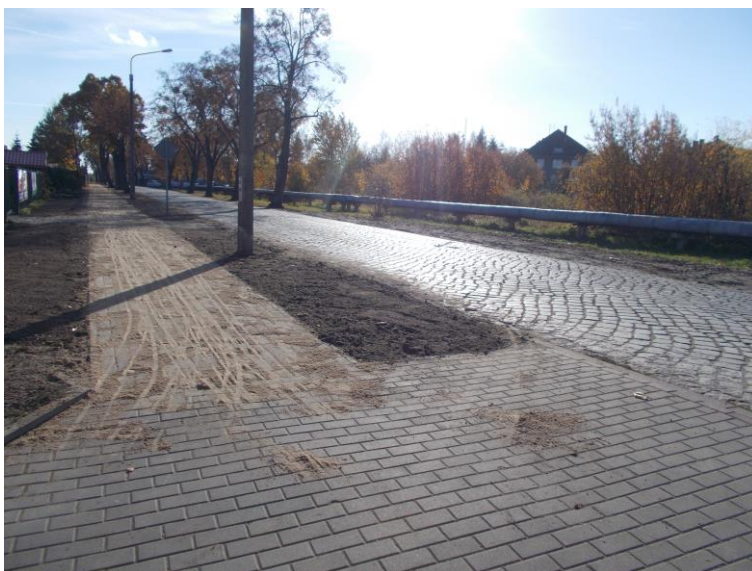
Remont nawierzchni chodnika w ciągu drogi powiatowej nr 1381N ul. Stefczyka w Braniewie
