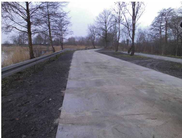
Ułożenie drogowych płyt betonowych w ciągu drogi powiatowej nr 2342N ul. Sportowa w Braniewie
