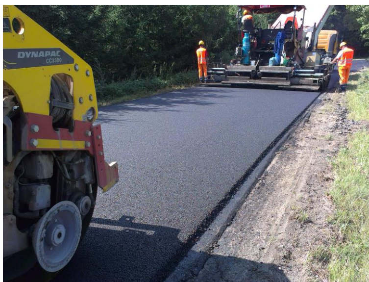
Warstwa wyrównawcza i warstwa ścieralna na odc. od drogi nr 504 do Krzyżewa
