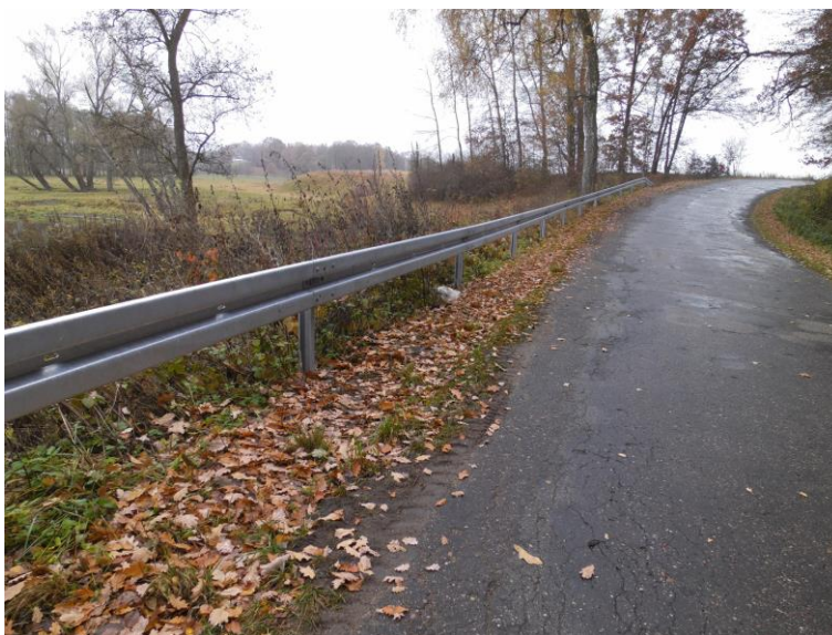
Montaż elementów bezpieczeństwa ruchu drogowego – stalowe bariery ochronne
