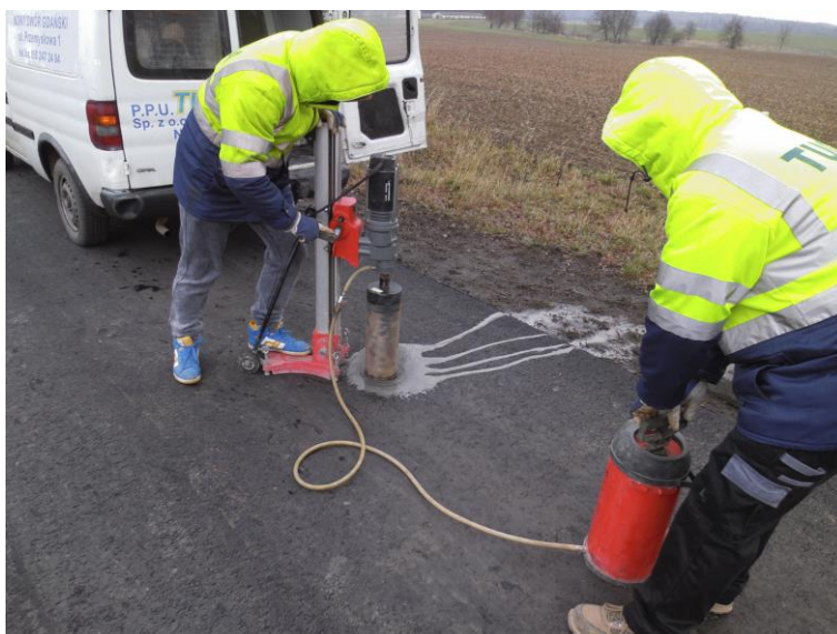
Badania laboratoryjne wykonanych robót drogowych- pobieranie próbek z nawierzchni jezdni
