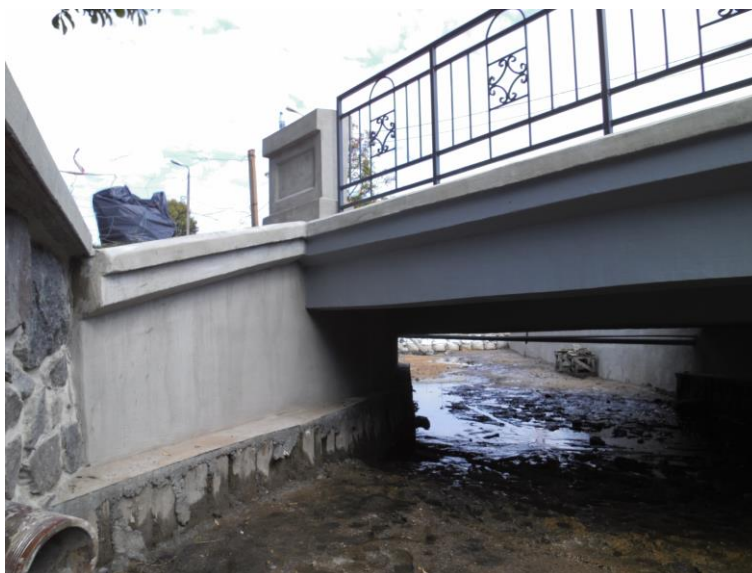
Naprawa obiektu mostowego w ciągu drogi powiatowej nr 2368N ul. Portowa we Fromborku
