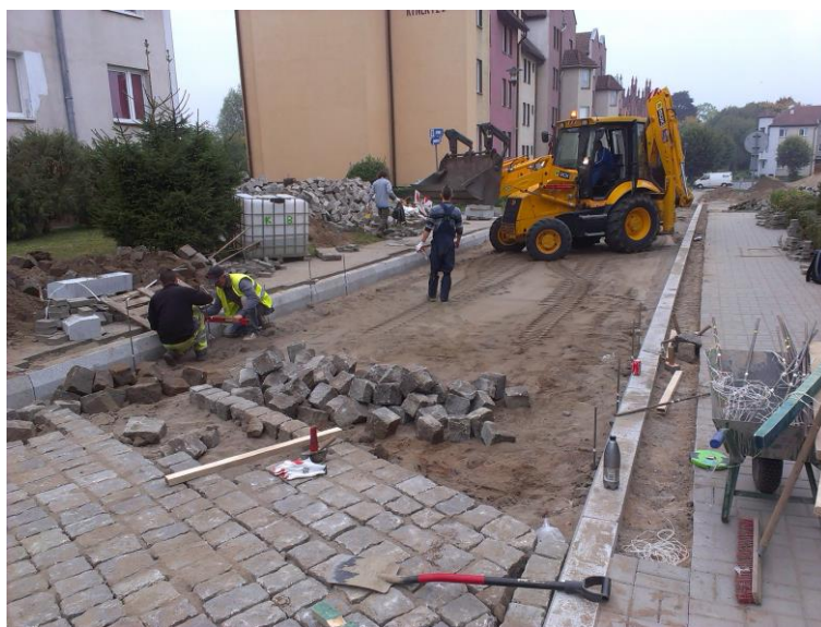
Remont nawierzchni z kostki kamiennej ul. Ornecka w Pieniężnie
