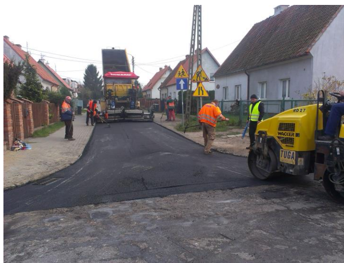
Poprawa warunków komunikacyjnych, naprawa nawierzchni jezdni w ciągu ulic powiatowych
