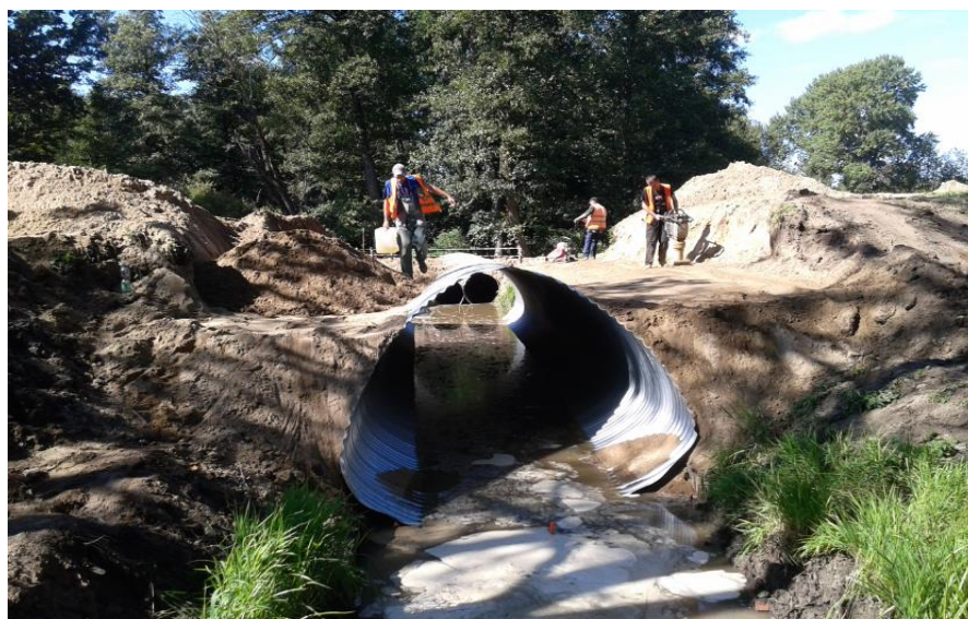
Przepust w ciągu DP 1397N w m. Wyszkowo w trakcie remontu
