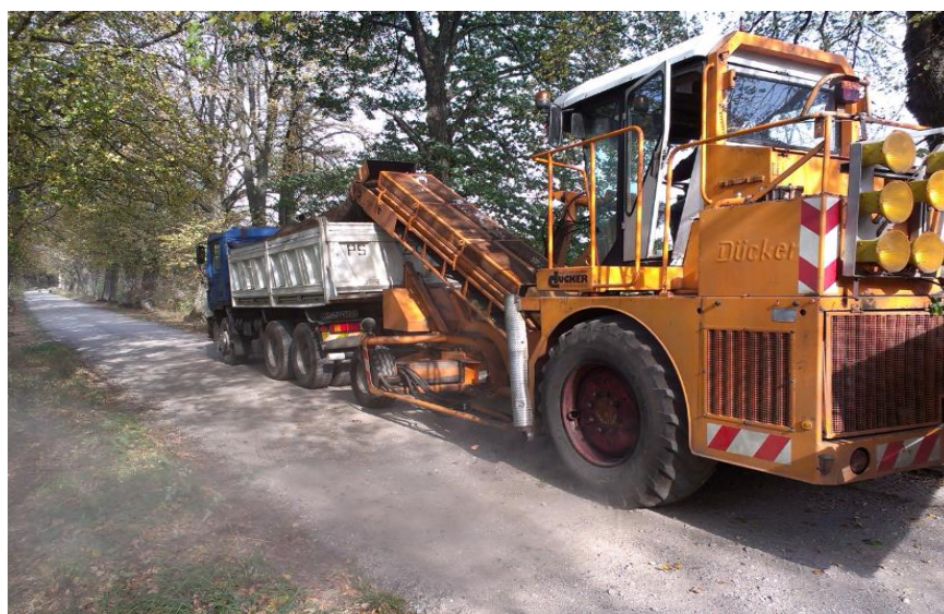
Ścinanie poboczy z wywozem ziemi z drogi nr 1395N odc. Jachowo- Lutkowo
