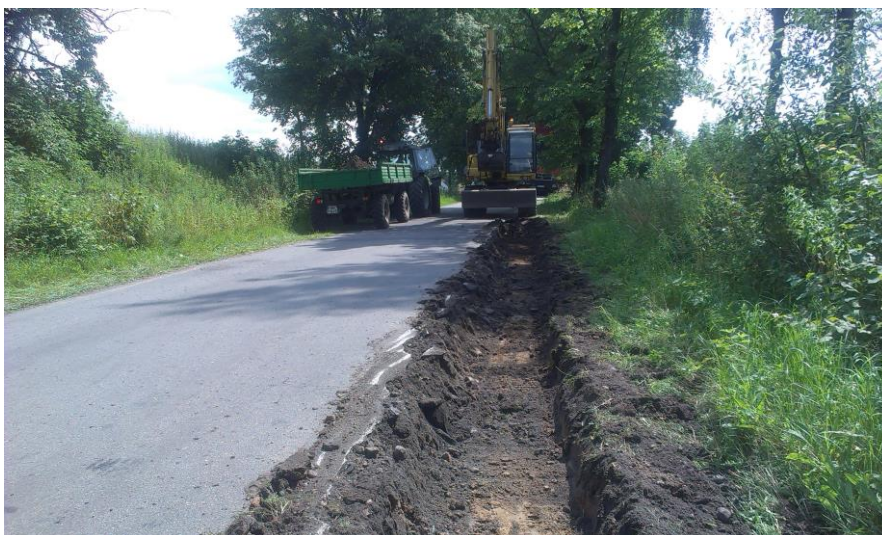
Przygotowanie konstrukcji pod poszerzenie jezdni DP 1320N Żelazna Góra- Grzędowo
