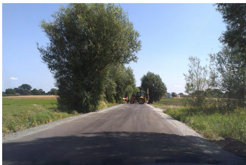
Likwidacja skutków zdarzeń kryzysowych- naprawa nawierzchni i poboczy DP 1314N Rogity
