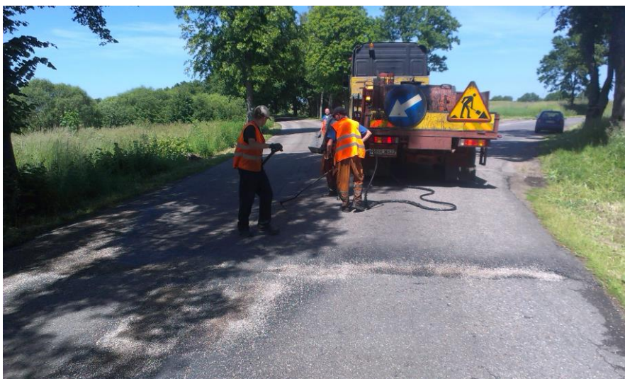
Remont nawierzchni dróg powiatowych- uzupełnienie wyboi i spękań grysami i emulsją
