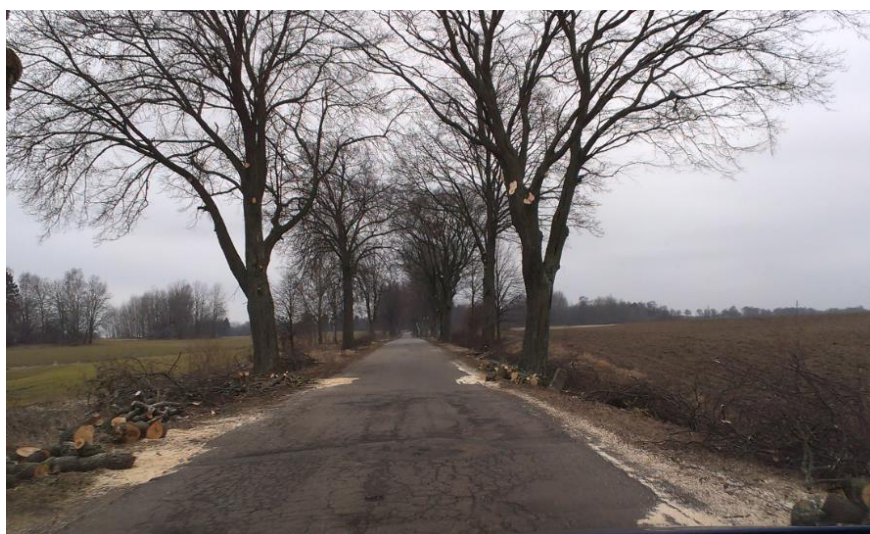
Pielęgnacja zadrzewienia na odcinku DP 1320N m. Krzekoty
