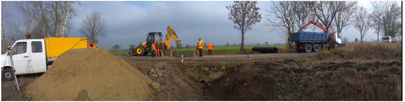
Przebudowa przepustu w ciągu DP 1377N Ułowo
