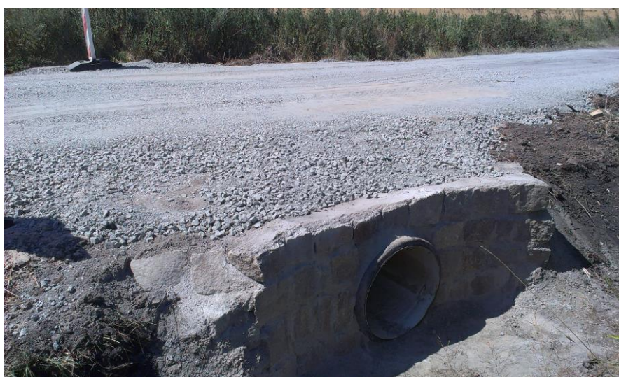
Likwidacja skutków zdarzeń kryzysowych- naprawa nawierzchni gruntowej i przepustu DP 1314N Świętochowo
