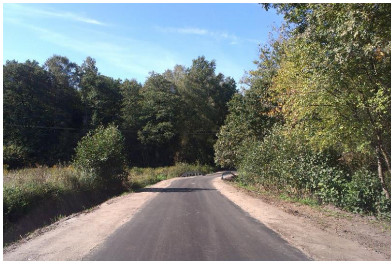
Przebudowa drogi powiatowej nr 1312N odc. Rusy- Zgoda (zrealizowane przez Gminę Braniewo)
