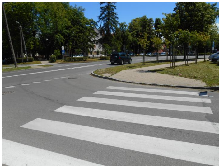
Malowanie oznakowania poziomego w ciągu dróg powiatowych
