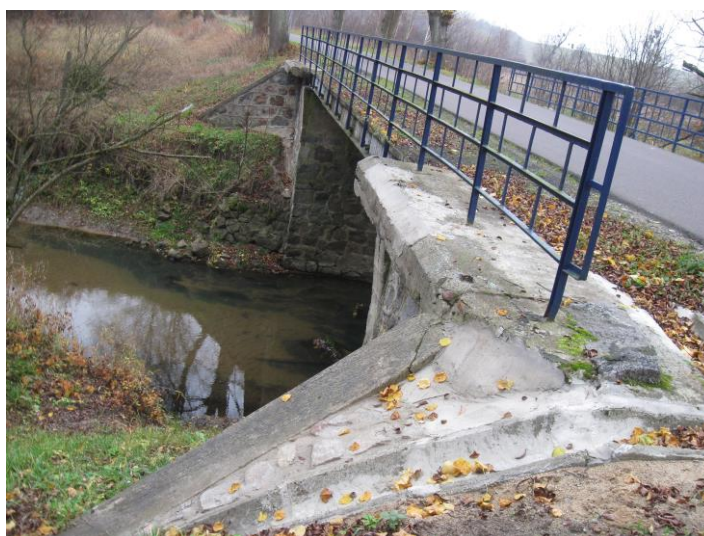
Naprawa skarp i odwodnienia obiektu mostowego
