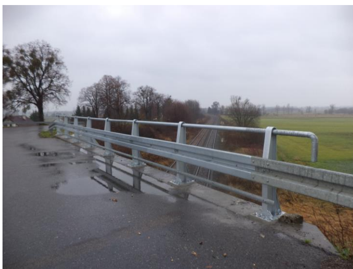
Montaż barieroporęczy ochronnych na wiadukcie w ciągu DP 1385N Bemowizna
