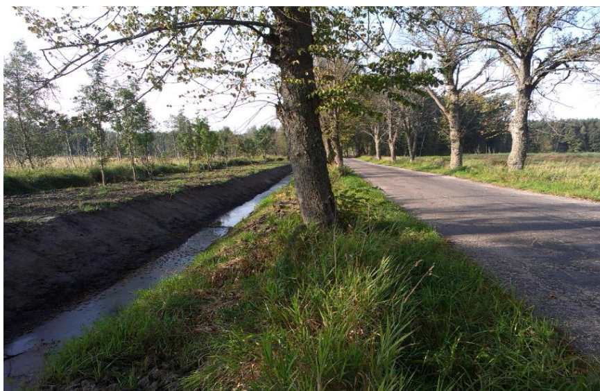
Odnowa rowów przydrożnych na odcinku DP 1397N Piele- Zagaje
