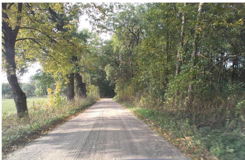
Profilowanie i uzupełnienie kruszywem nawierzchni gruntowej drogi nr 1334N odc. Wołowo- Wilkńity
