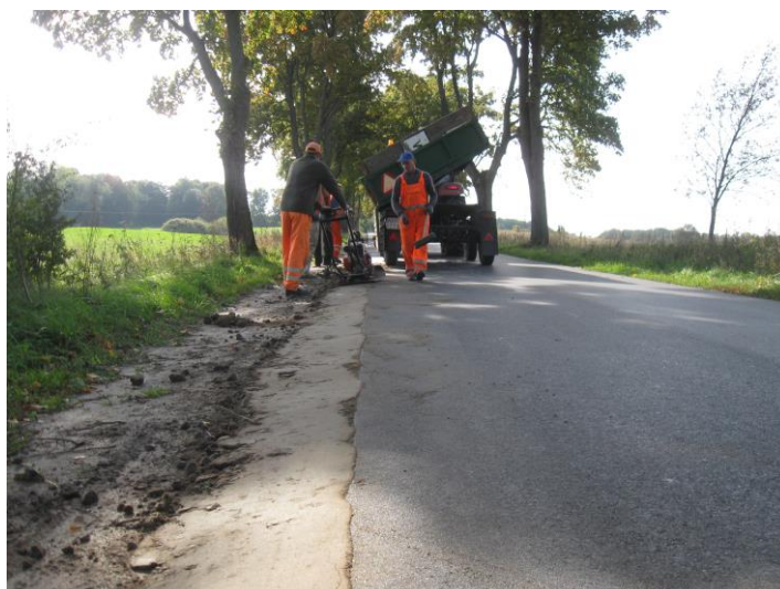
Uzupełnianie i wzmacnianie poboczy przy nowych nawierzchniach dróg
