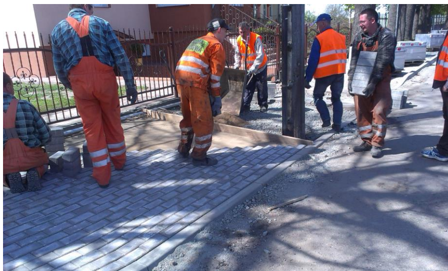
Naprawa nawierzchni chodników w ciągu ulic powiatowych
