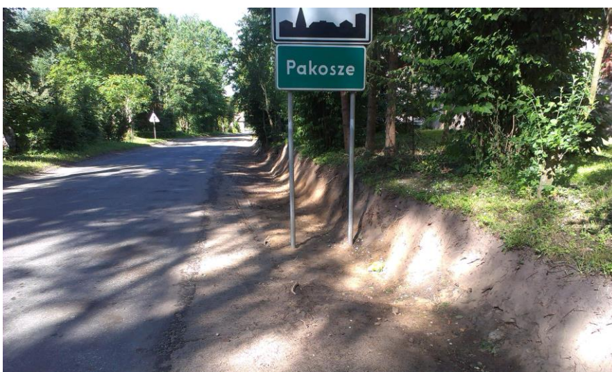
Poprawa odwodnienia, ścinanie zawyżonych poboczy DP 1342N Długobór- Pakosze
