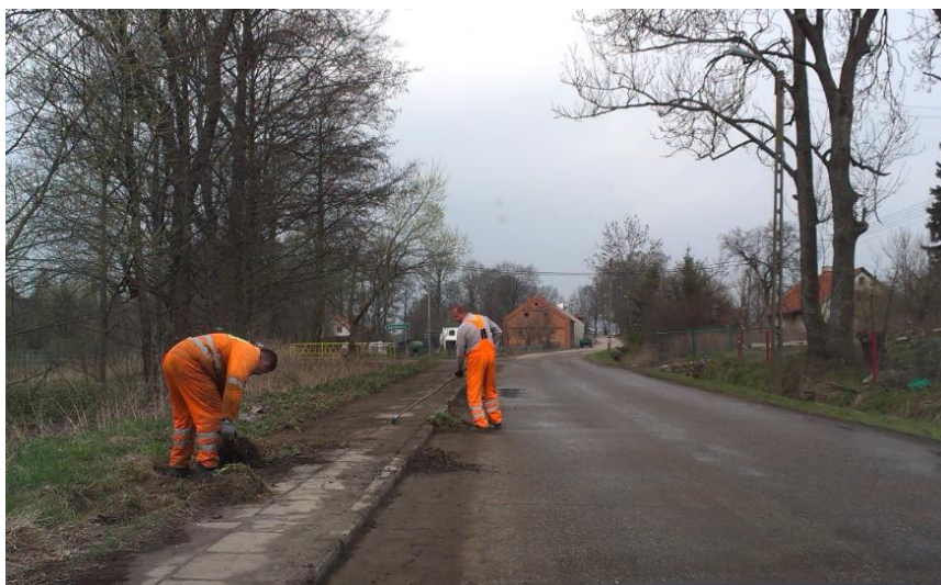
Sprzątanie nawierzchni chodników i jezdni w ciągu dróg powiatowych
