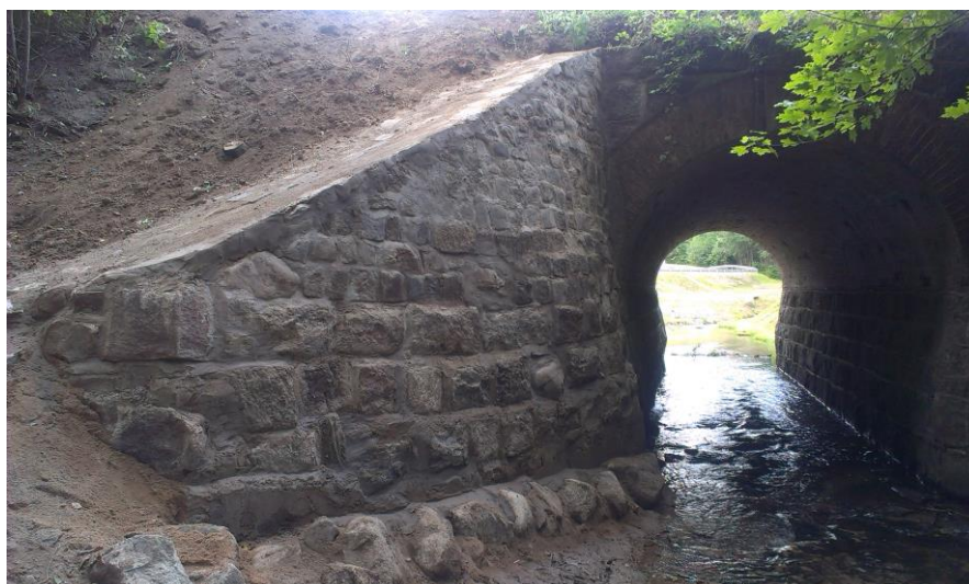
Odbudowa zniszczonych ścian skrzydeł i przyczółków przepustów kamiennych pod DP 1393N
