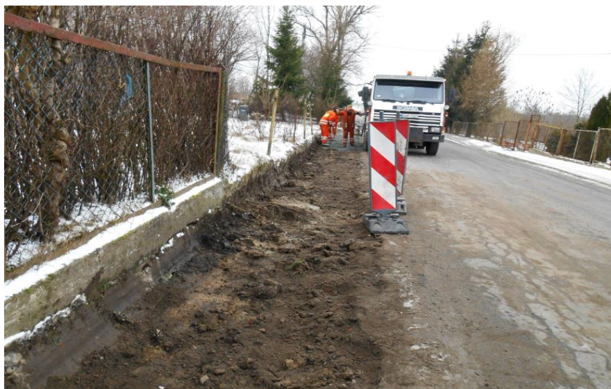
Umacnianie poboczy kruszywem kamiennym w ciągu DP 1397N w m. Wyszkowo
