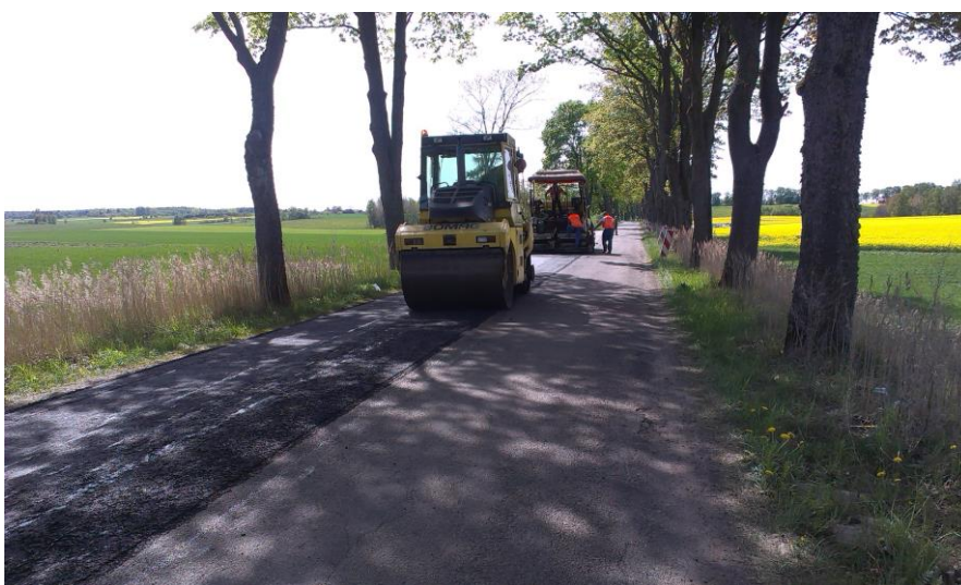
Układanie warstwy wyrównawczej DP 1330N odc. Czosnowo- Dąbrowa
