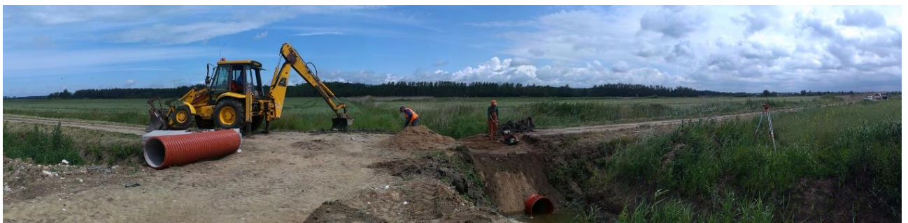
Remont przepustu pod drogą powiatową nr 1379N Stara Pasłęka- Braniewo
