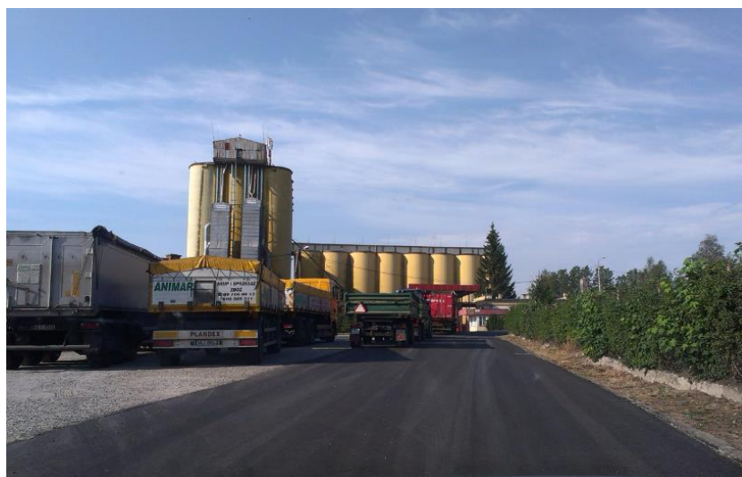
Naprawa ul. Cmentarnej w Pieniężnie nawierzchnia w technologii SMA pod ruch ciężki
