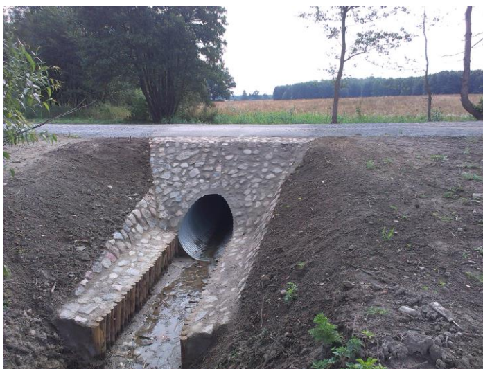
Remont przepustów pod drogą powiatową nr 1383N na odc. Lipowina- Kiersy
