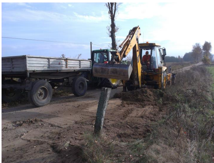
Zbieranie zawyżonych poboczy na odcinkach dróg gruntowych
