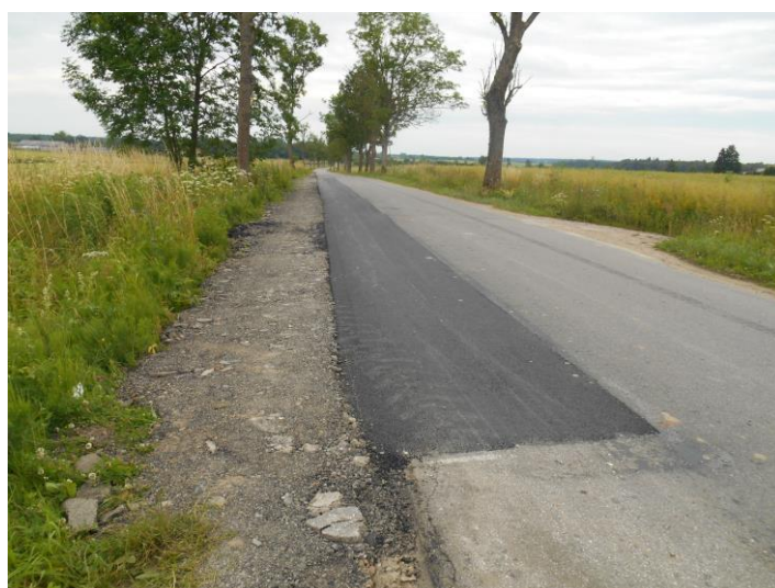
Wykonanie robót poprawkowych uszkodzonej nawierzchni w ramach gwarancji jakości
