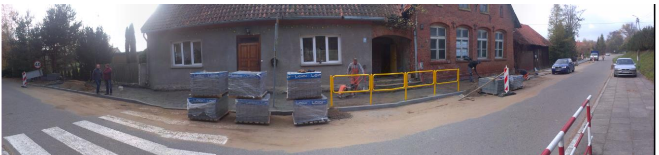
Remont ciągu pieszego przy drodze powiatowej nr 1387N w Szylenach
