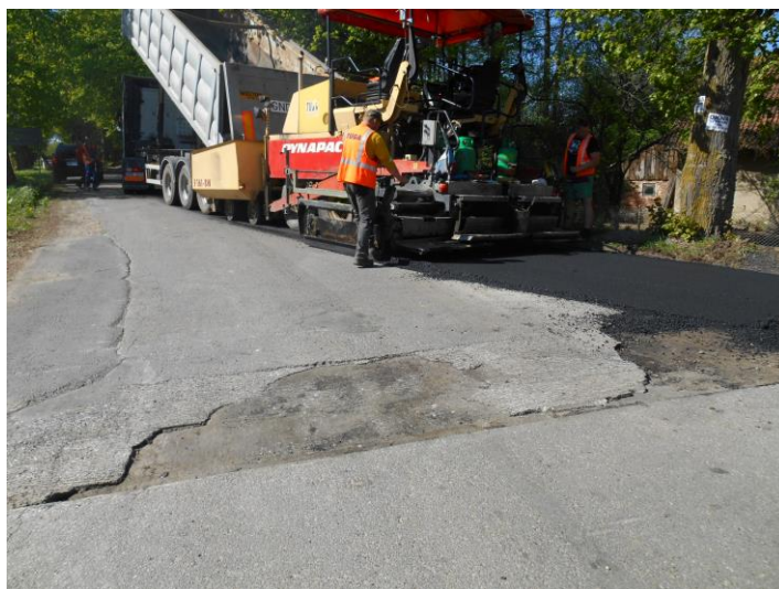
Remont nawierzchni jezdni DP 1154N Słobity- Łukszty
