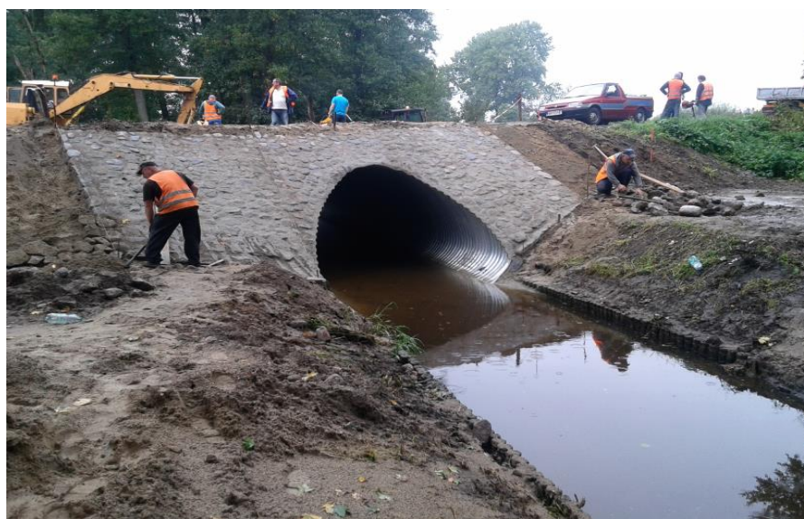
Usuwanie skutków zdarzeń kryzysowych- remont przepustu w ciągu DP 1397N w m. Wyszkowo
