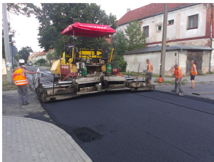
Naprawa nawierzchni jezdni ulic powiatowych- układanie warstwy ścieralnej w technologii MNU
