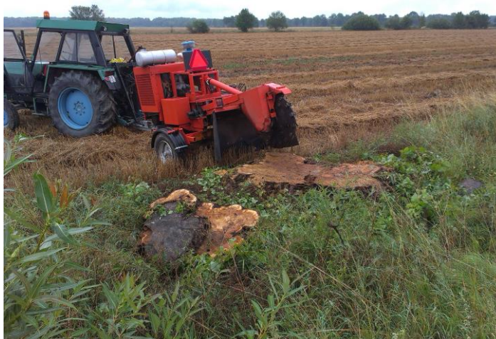
Frezowanie pni po wycince drzew z pasa drogowego DP 1316N Kalinowiec
