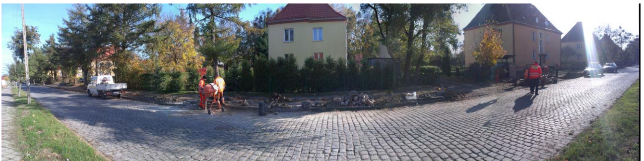
Naprawa nawierzchni chodnika w ciągu Alei Wojska Polskiego w Braniewie
