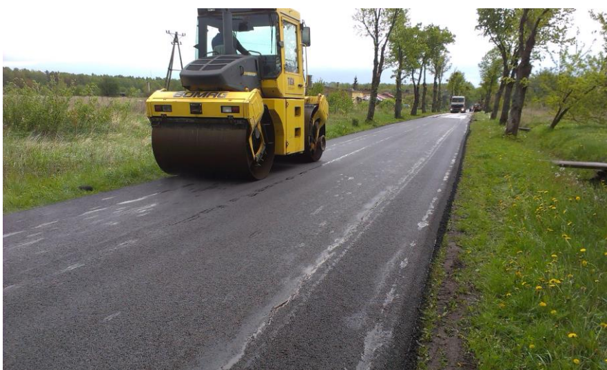
Likwidacja kolein- remont nawierzchni jezdni DP 1165N Biedkowo
