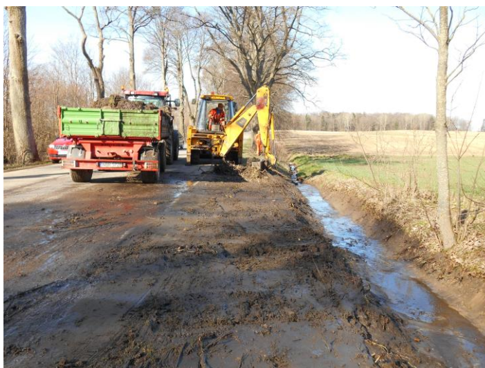
Oczyszczanie i pogłębianie rowów przy drodze powiatowej nr 1385N w Strubnie
