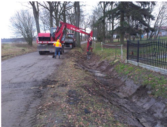
Oczyszczanie rowów przydrożnych z karczowaniem krzaków DP 1308N Chruściel- Wielkie Wierzno
