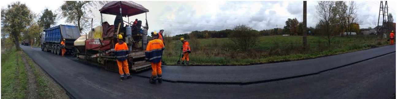
Remont nawierzchni jezdni w ciągu DP 1381N Braniewo- Zawierz
