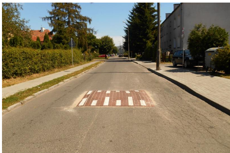
Budowa progów zwalniających
