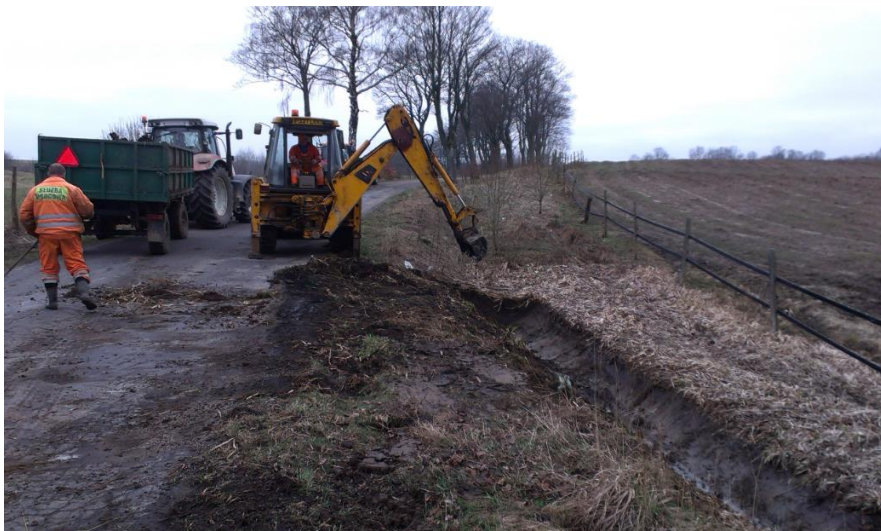
Poprawa odwodnienia DP 1322N Grabowiec- Głębock
