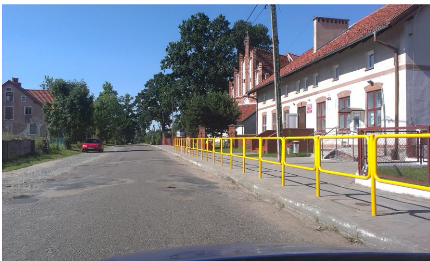
Ustawienie balustrad ochronnych przy szkole DP 1340N w Wilczętach
