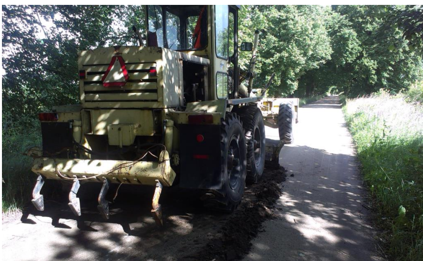
Profilowanie nawierzchni gruntowej drogi nr 1395N odc. Jachowo- Lutkowo
