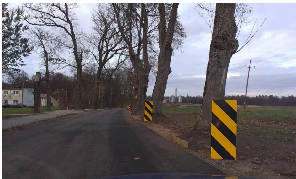
Oznakowanie pionowe drzew w skrajni drogi powiatowej nr 1391N
