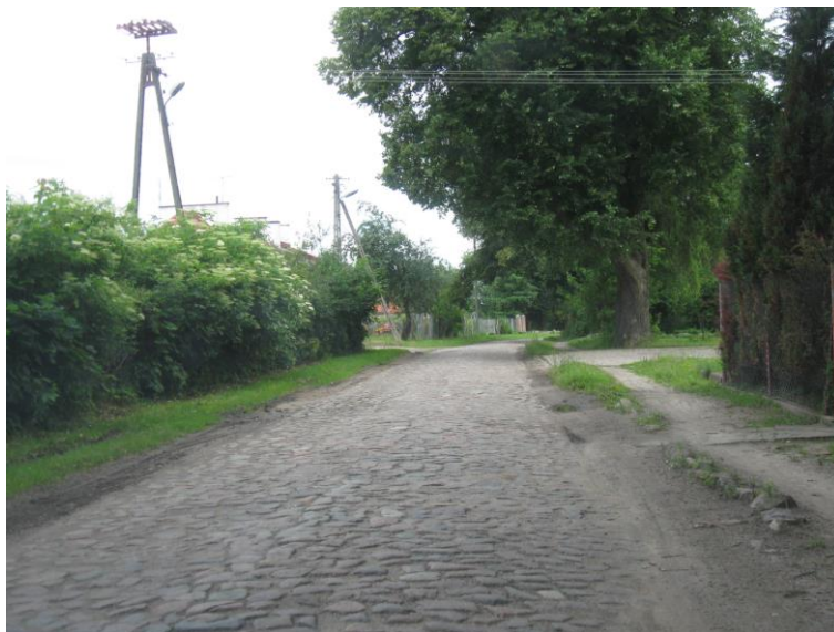
DP Nr1391N m. Podleśne - przed wykonaniem
