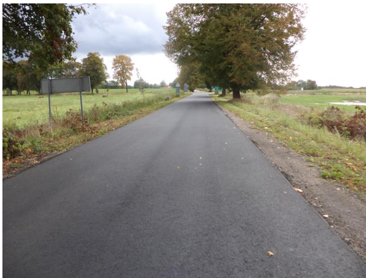
Poprawa warunków komunikacyjnych w ciągu drogi powiatowej nr 1320N Lutkowo–Siekiera
