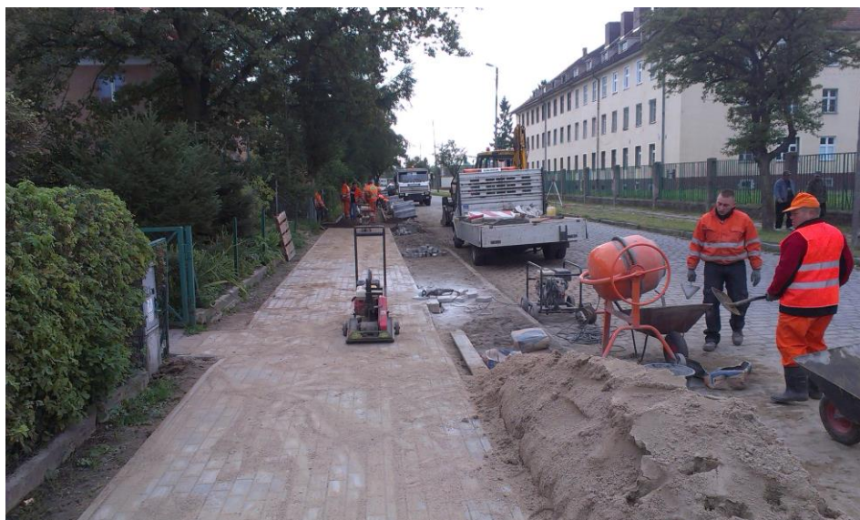
Remont ciągu pieszego na ul. Aleja Wojska Polskiego w Braniewie
