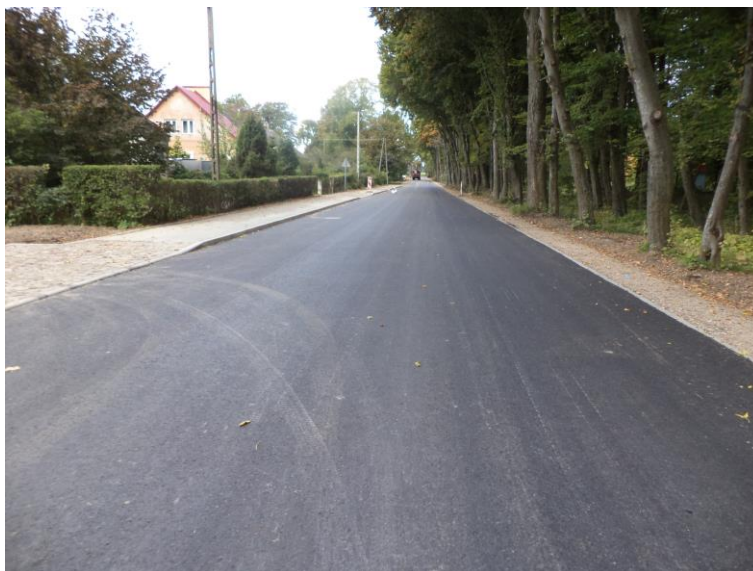
DP Nr 1391N m. Gronowko - po wykonaniu
