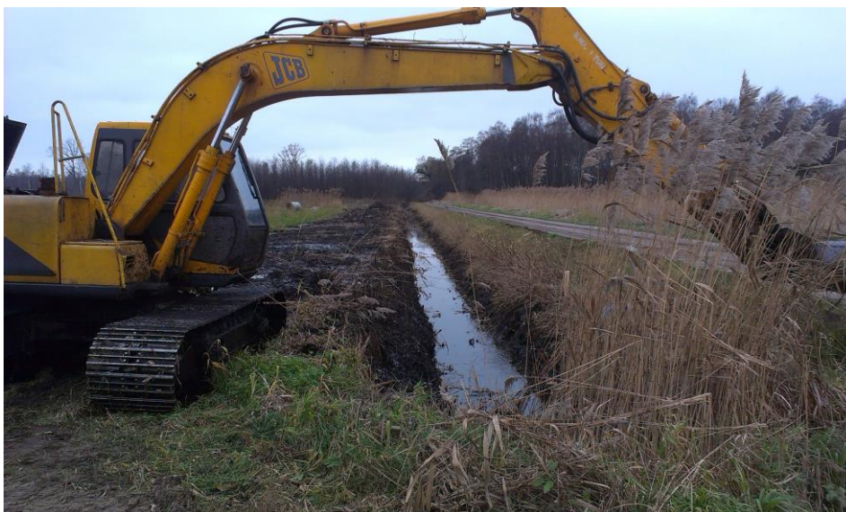
Odnowa i konserwacja rowów przydrożnych odc. DP nr 1310N Klejnowo- Różaniec
