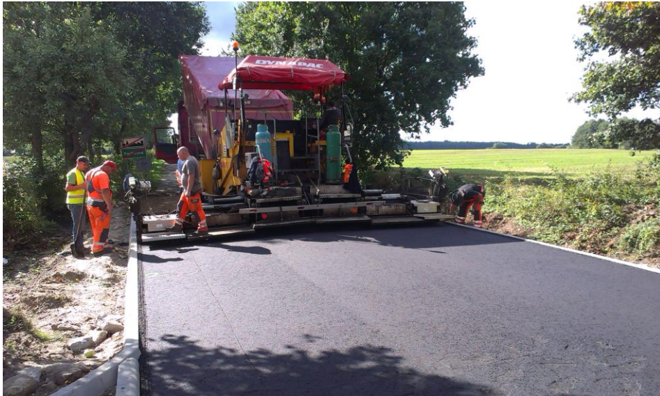
Przebudowa drogi powiatowej nr 1391N m. Podleśne oraz Gronówko układanie nawierzchni jezdni
