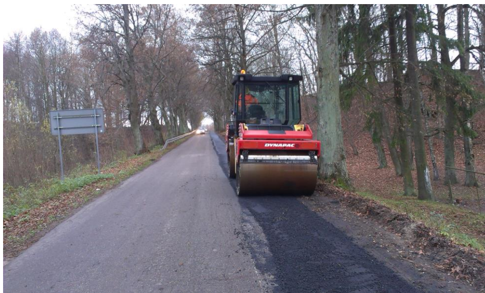
Naprawa poboczy betonem asfaltowym DP nr 1154N odc. Słobity- granica powiatu
