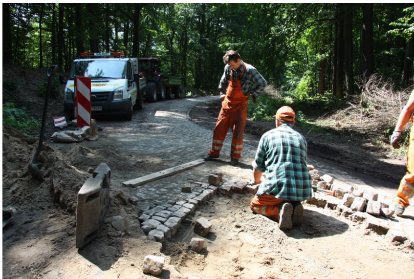
Naprawa uszkodzeń nawierzchni z kostki kamiennej w ciągu DP nr 1171N
