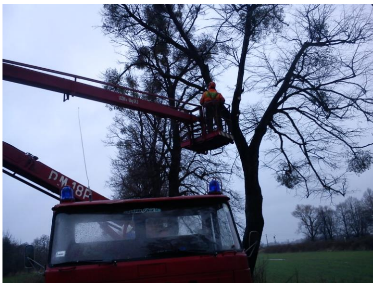
Wycinka, usuwanie drzew przydrożnych
