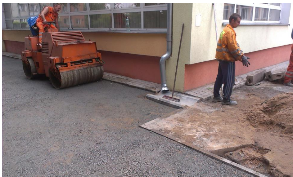
Naprawa nawierzchni parkingu na terenie Starostwa Powiatowego
