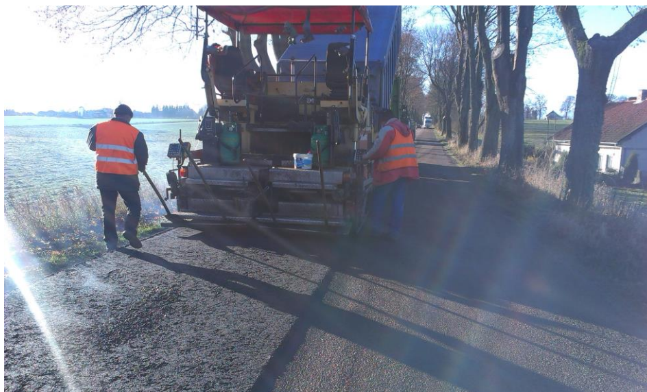
Wyrównanie kolein betonem asfaltowym, podczas realizacji zadania: Poprawa warunków komunikacyjnych w ciągu drogi powiatowej nr 1330N odc. Dąbrowa- Czosnowo
