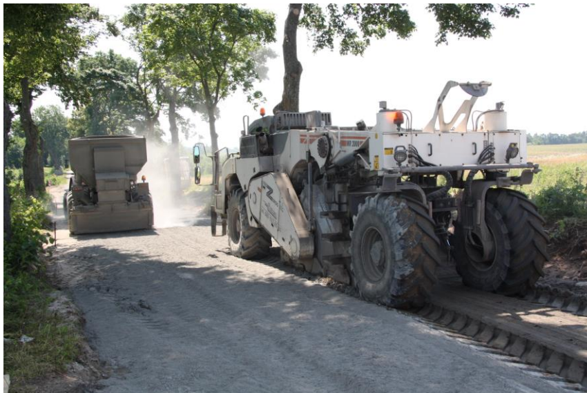
Przebudowa drogi powiatowej nr 1391N m. Podleśne oraz Gronówko stabilizacja warstw podbudowy
