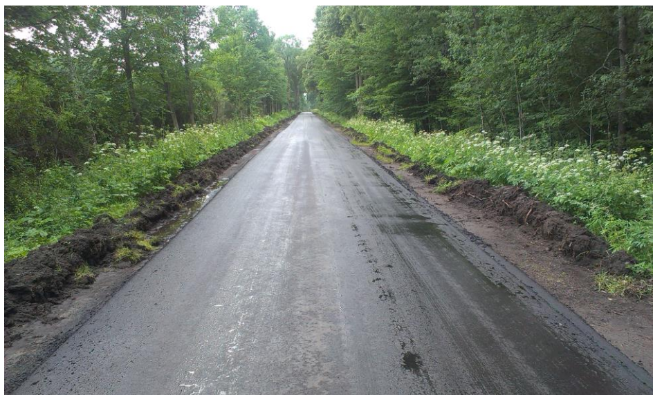
Naprawa kolein w ciągu drogi powiatowej nr 1308N odc. Baranówka-Wielkie Wierzno
