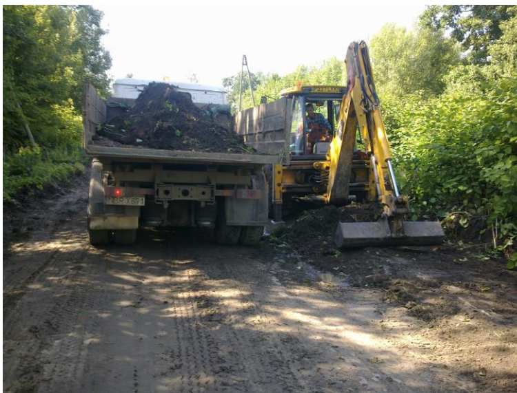
Zbieranie i wywóz nadmiaru ziemi z poboczy drogi brukowej w m. Jachowo
