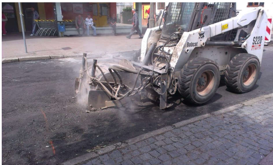
Frezowanie nawierzchni podczas realizacji zadania Poprawa warunków komunikacyjnych w ciągu drogi powiatowej nr 2363N ul. Mickiewicza we Fromborku
