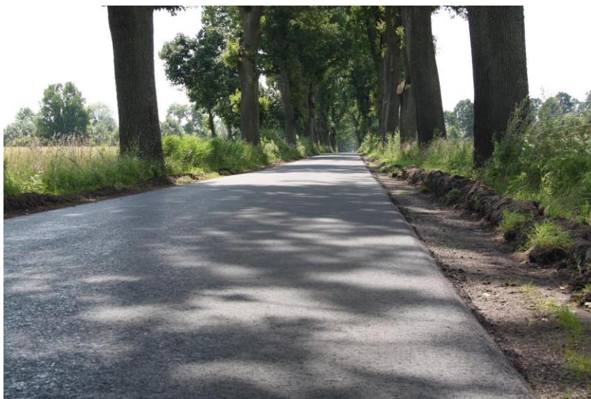
Naprawa kolein w ciągu drogi powiatowej nr 1161N odc. Spędy-Dobry
