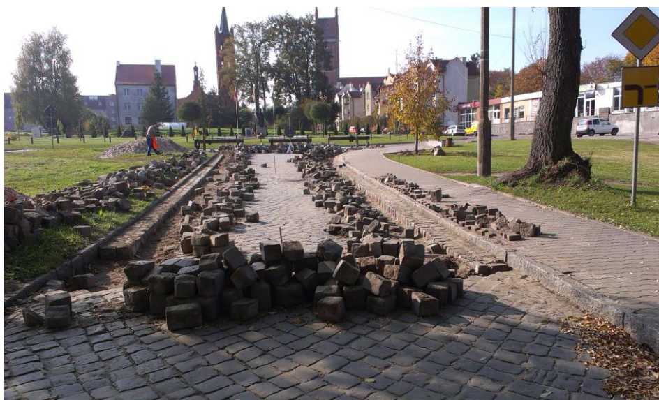
Naprawa nawierzchni brukowej jezdni ul. Rynek w Pieniężnie (przy współpracy z UMiG Pieniężno)
