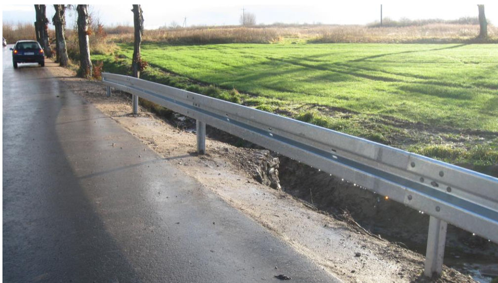
Ustawienie barier ochronnych sprężystych nad przepustem – DP 1391N
