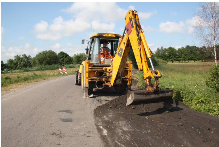
Poprawa odwodnienia- ścinanie zawyżonych poboczy przy drogach powiatowych
