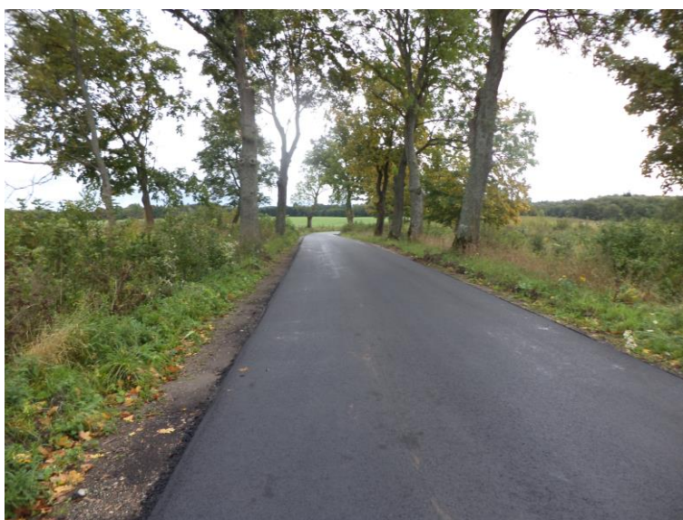
Poprawa warunków komunikacyjnych w ciągu drogi powiatowej nr 1393N Krzewno–Gronówko
