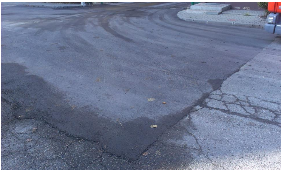
Naprawa uszkodzeń nawierzchni jezdni ul. Kościelnej w Braniewie wykonana przy współpracy z MPEC Sp. z o.o.
