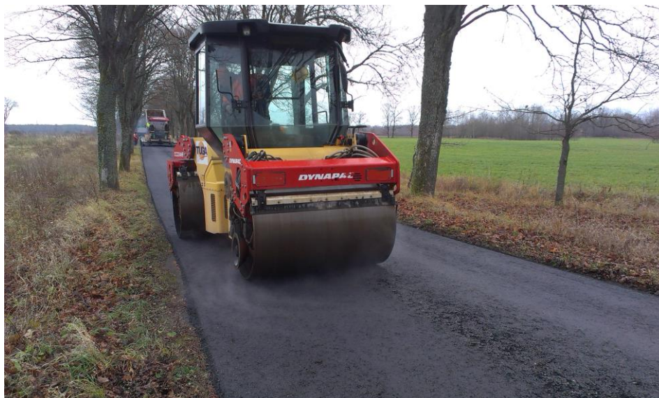
Naprawa nawierzchni bitumicznej drogi powiatowej nr 1165N odc. Drewnowo- Biedkowo Osada
