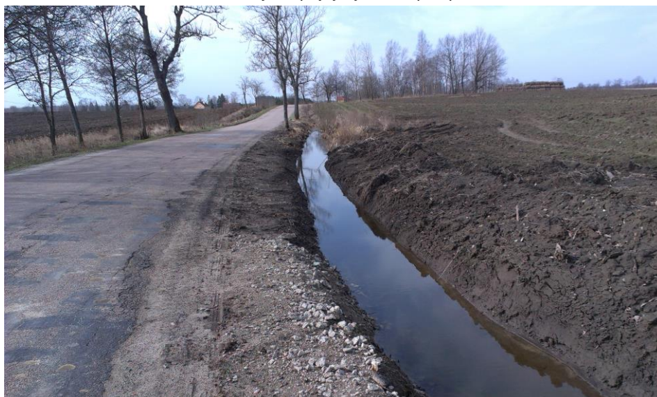
Oczyszczenie rowów i umocnienie pobocza DP 1397N odc. Piotrowiec- Wyszkowo
