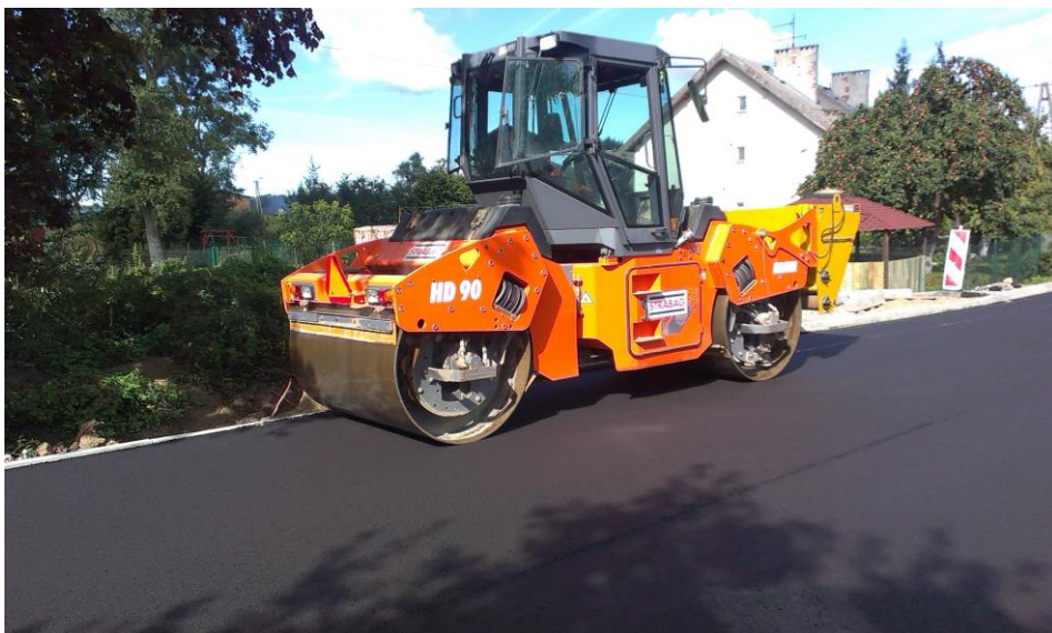
Przebudowa drogi powiatowej nr 1391N m. Podleśne oraz Gronówko układanie warstw konstrukcji jezdni
