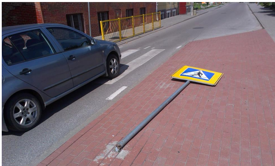
Zniszczone oznakowanie pionowe- do wymiany
