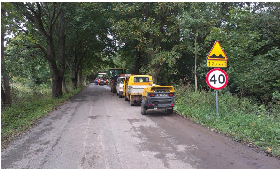
Poprawa warunków komunikacyjnych w ciągu drogi powiatowej nr 1381N Braniewo–Zawierz
