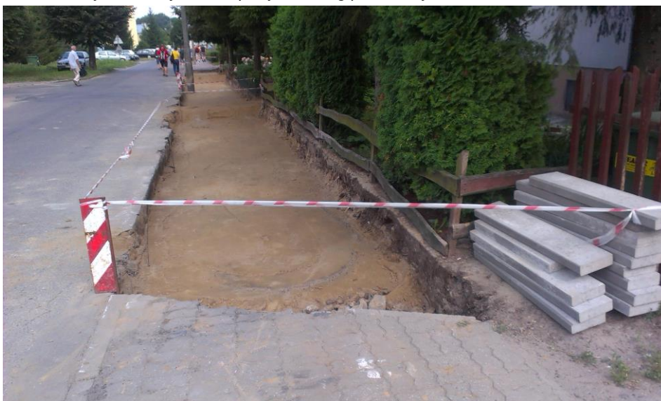
Wykonanie podbudowy pod remontowany chodnik na ul. Grota Roweckiego w Braniewie
