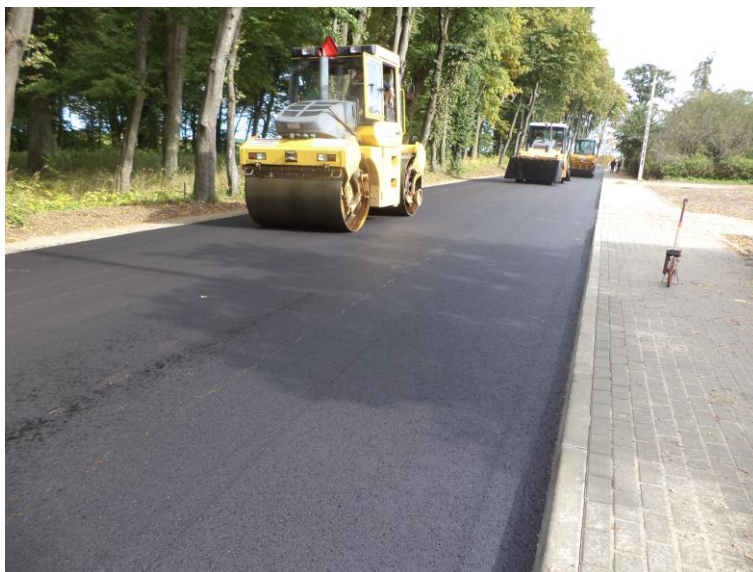
Przebudowa drogi powiatowej nr 1391N m. Podlesne oraz Gronowko układanie nawierzchni jezdni
