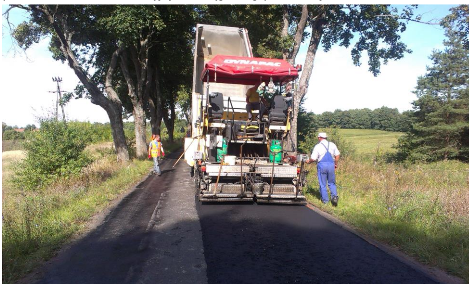
Układanie warstwy wyrównawczej w ramach zadania: Poprawa warunków komunikacyjnych w ciągu drogi powiatowej nr 1397N Bornity–Glebiska
