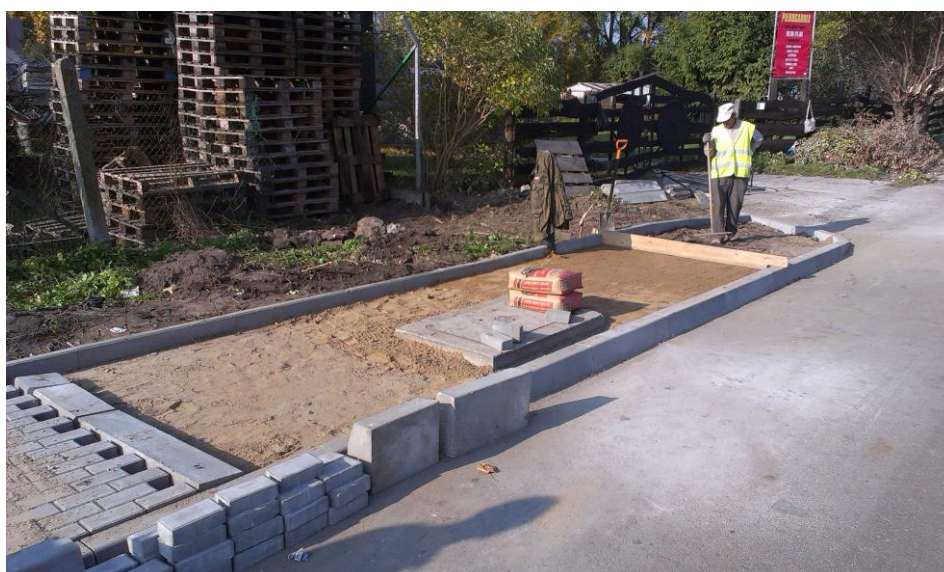
Remont chodnika na ul. Królewieckiej w Pieniężnie (przy współpracy z UMiG Pieniężno)
