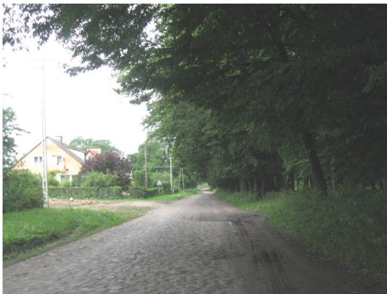
DP Nr1391N m. Gronówko - przed wykonaniem
