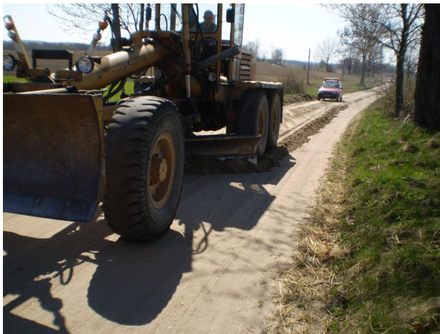
Profilowanie nawierzchni dróg gruntowych
