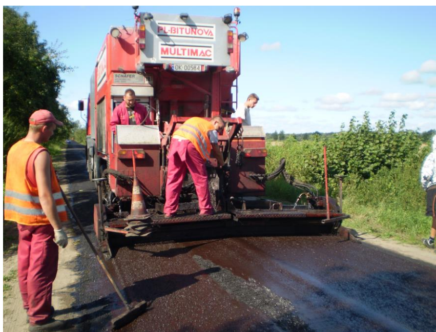
Wykonanie nowych nawierzchni metodą mikrodrywanu
