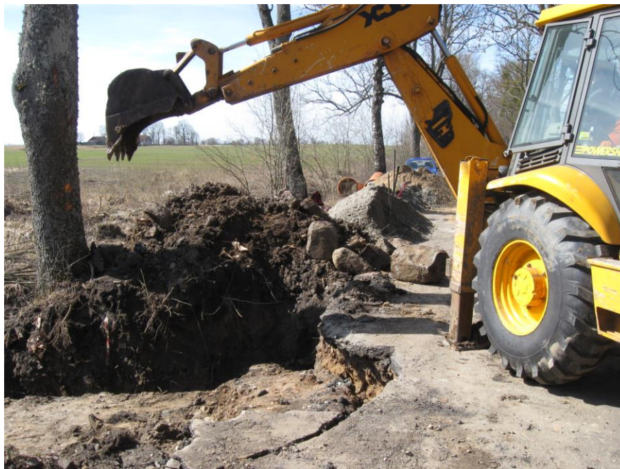
Remont przepustu pod drogą nr 1346N w m. Jesionowo
