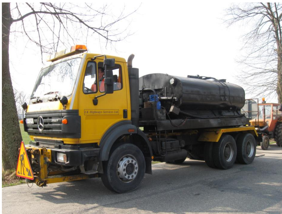
Bieżący remont nawierzchni grysami i emulsją
