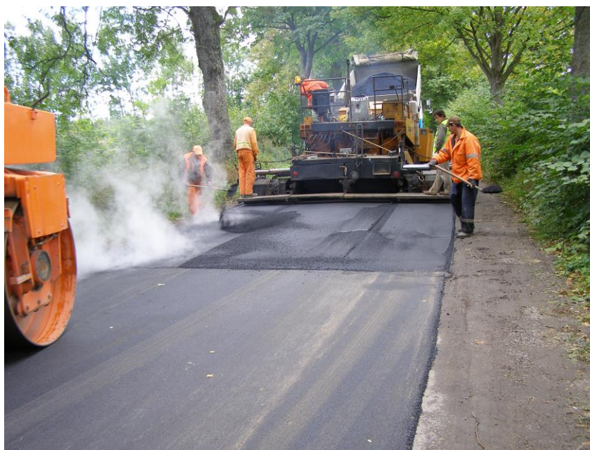
Wykonanie nowych nawierzchni- wyrównanie masą bitumiczną
