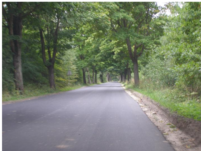
Odcinek drogi powiatowej Dąbrowa - Chruściel
