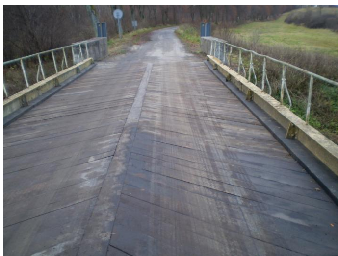
Remont obiektu mostowego w m. Bogdany
