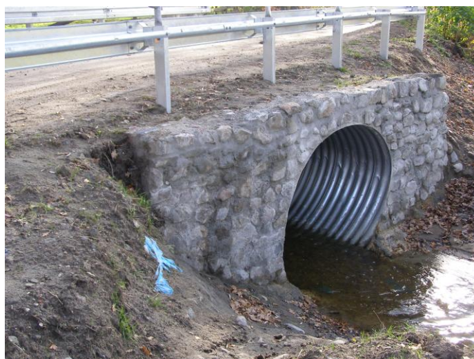
Remont przepustu w m. Lubnowo
