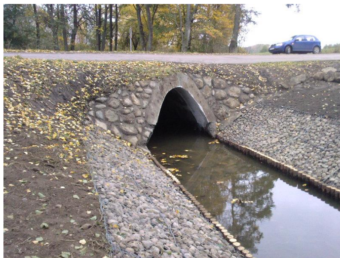
Remont przepustu w m. Wyszkowo
