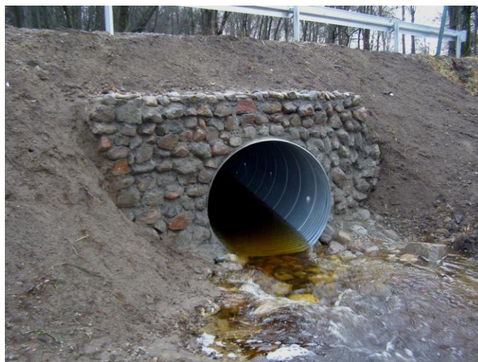
Remont przepustu w m. Piele
