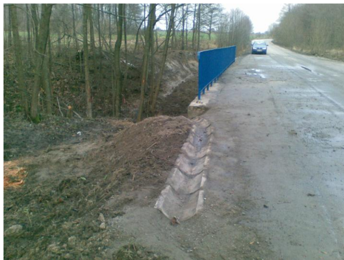
Remont obiektu mostowego w m. Marcinkowo
