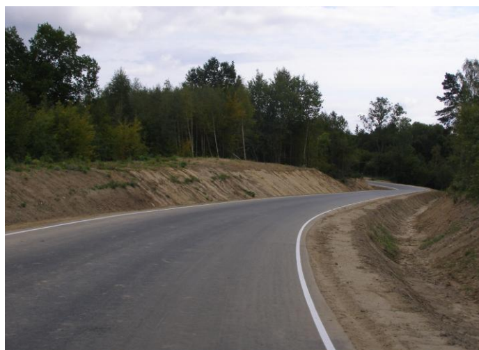
Nowa droga powiatowa odc. Kalinowiec – Pęciszewo
