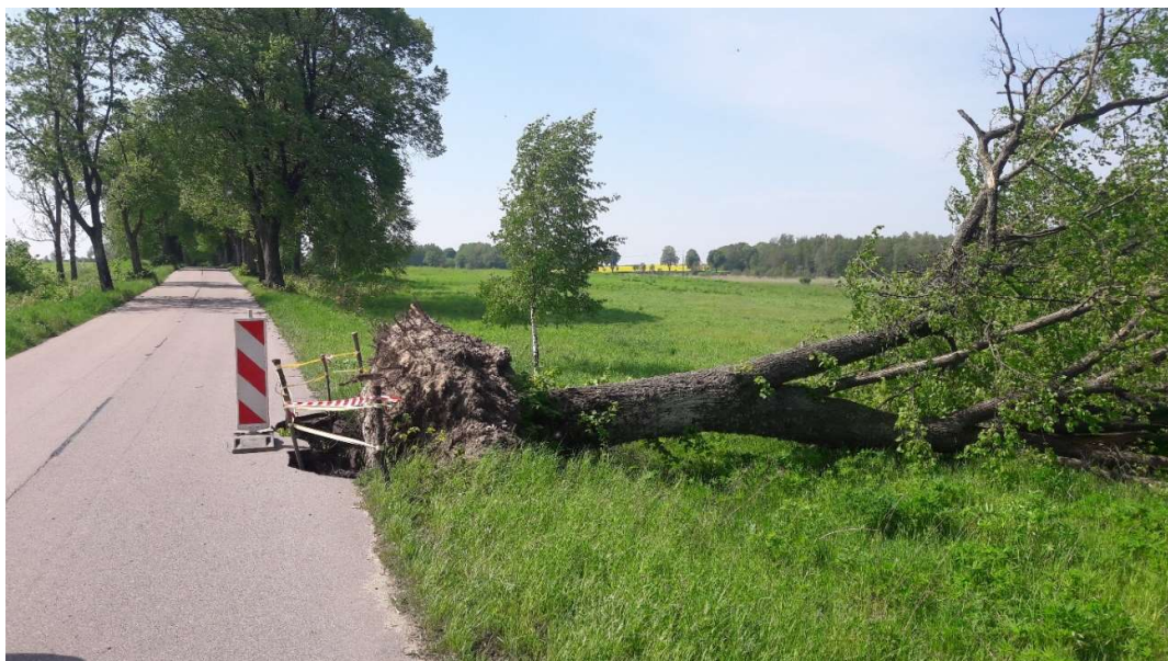
Fot.1. Uszkodzenie jezdni w wyniku wywrócenia się drzewa DP 1397N odc. Bieńkowo – Wyszkowo
