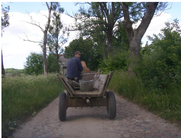
Fot. Wąskie pasy ruchu na drogach powiatowych utrudniają poruszanie się pojazdami, w połączeniu z drzewami w poboczu stwarzają bezpośrednie zagrożenie brd
