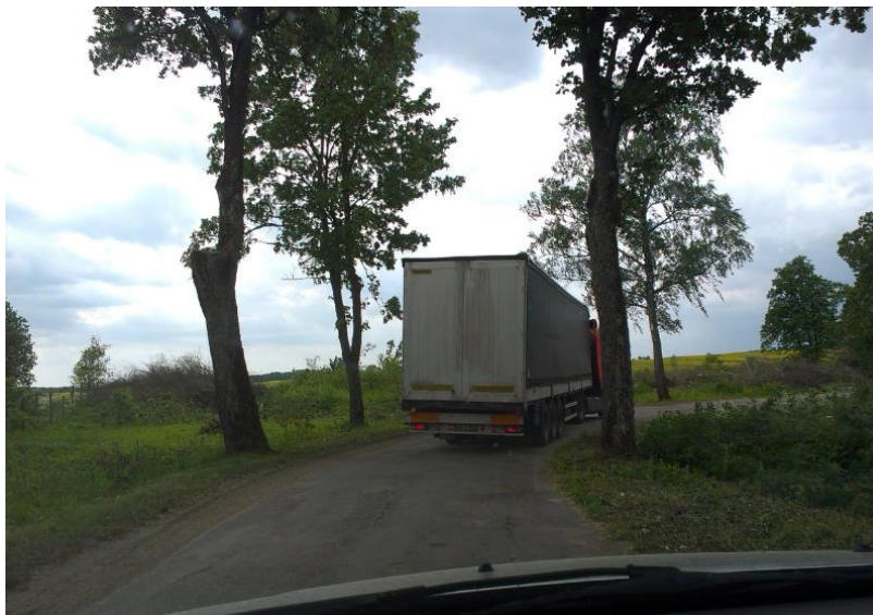
Fot. Wąskie pasy ruchu, nienormatywne łuki dróg powiatowych, zadrzewienie w poboczach i ruch pojazdów ciężkich- w celu poprawy brd konieczne przedsięwzięcia inwestycyjne związane z przebudową i usunięciem drzew. W ramach działań przy bieżącym utrzymaniu dróg prowadzona jest naprawa nawierzchni i poprawę widoczności- usunięte krzaki, odrosty i konary w skrajni dróg.
